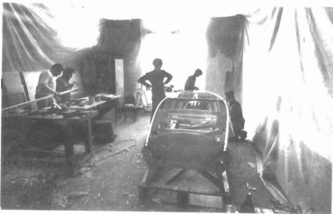
L'installation du chantier sous la tente
