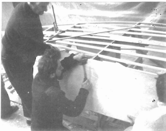
Pose du bordé tribord. Les lignes de pointage sont tracées au préalable.
