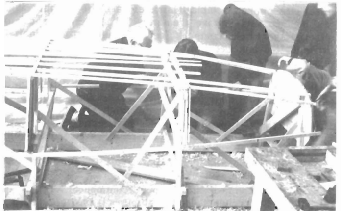
Pose des serres
