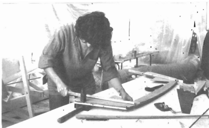
Les baguettes permettront de pointer les bordés sur les cloisons
